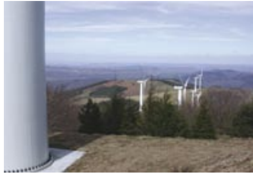
Windpark auf einem Bergrücken am Rande eines Rotbuchenwaldes (Aveyron, Frankreich), gebaut im Jahre 2002. Zu dieser Zeit war über die Auswirkungen von Windenergieanlagen auf Fledermäuse noch nicht viel bekannt und keine Untersuchung zu Fledermäusen gemacht worden.
