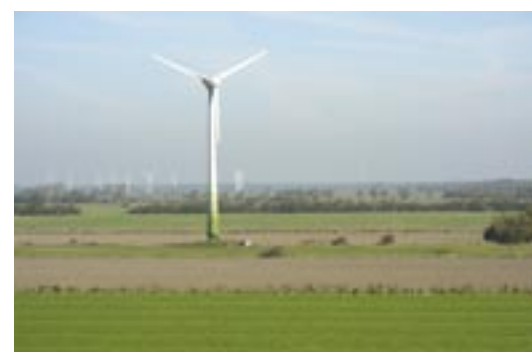
Windpark in Norddeutschland. Jagdhabitats von Breitflügelfledermäusen ( Eptesicus serotinus ) und Zwergfledermäusen ( Pipistrellus pipistrellus ) findet man in dieser strukturierten Landschaft regelmäßig. Um Schlagopfer zu vermeiden, sollte ein Mindestabstand von 200 m zu solchen Vegetationsstrukturen eingehalten werden.
